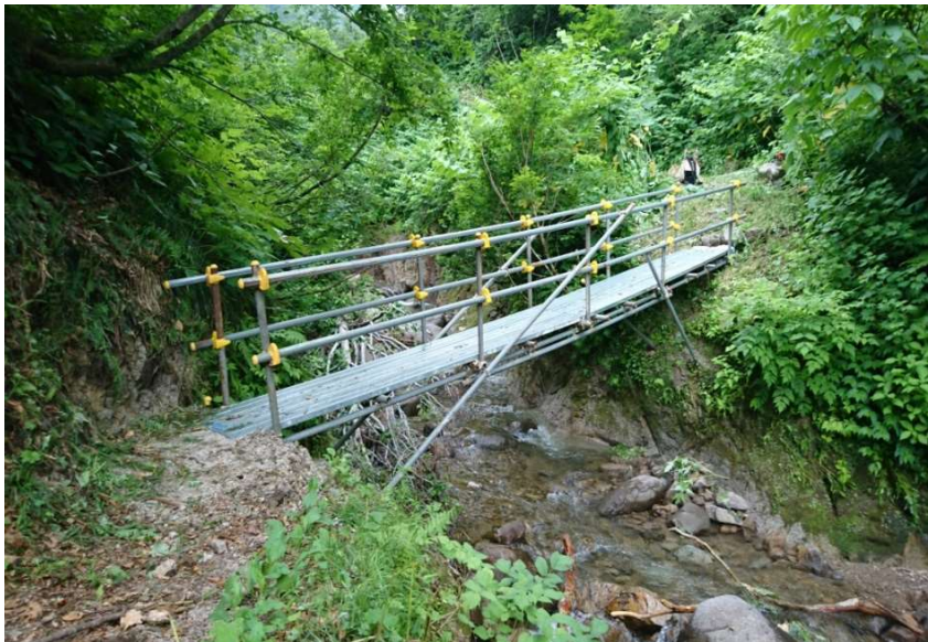
中荒沢万年雪遊歩道 唯一橋（単管足場パイプ）
