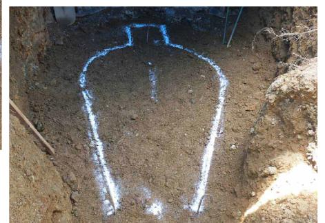
窯の大きさ（4尺×6尺）と煙導、焚き口の位置関係を石灰で作図する。
