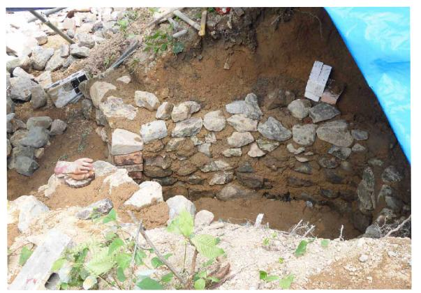
内部の側面から石組みを開始する。石の大きさと形の方向性を見極めながら一段づつ組むので、熟練の技が必要だ。そして石組みが崩れず、隙き間から熱がもれないようにミキサーで練った土を叩き付けるよう隙き間を埋めていく。
