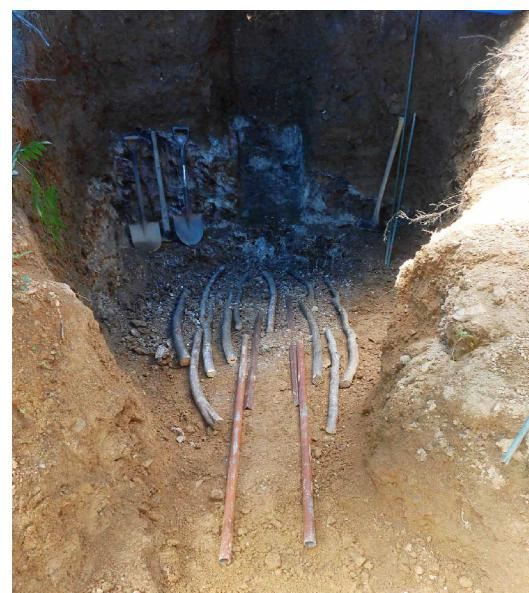
窯の床には、単管と木の枝、小石を敷き熱で発生する炭材の樹液を除く処置を施す。その上に鉄板を伏せ山土を敷いた。
