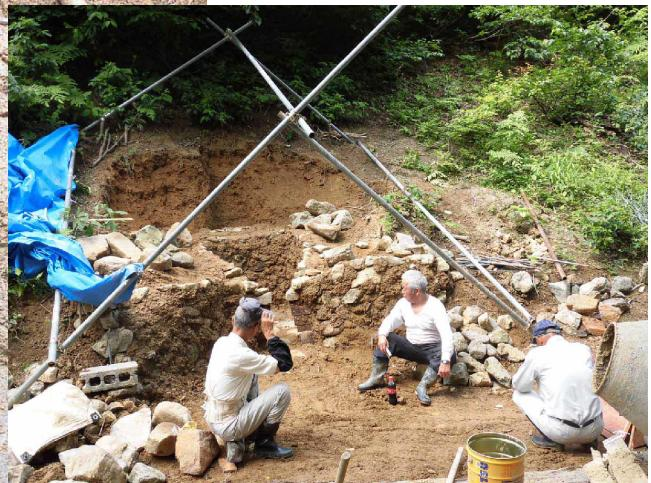
石の大小、形が違っていても相互にかみ合い補強し合うように石を積み上げていく。側面が完成したとき、熟練を駆使して秩序よく並だ構造美に息を呑むほどだった。
